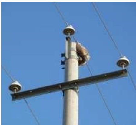
图片 3,4: 有顶针绝缘子和死掉的猎隼的电塔，蒙古（照片：A. Dixon）和经过改造的、对鸟类安全的电塔（照片：O. Dorjsuren）。
