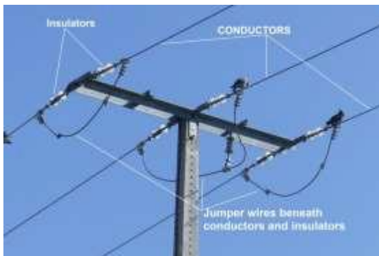
图片 2：应变式绝缘子的正确设计实例（与终端绝缘子的配置相同）（照片：J. Martin Martin & A. Camiña）
