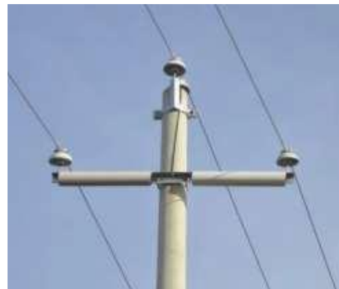
图片 3,4: 有顶针绝缘子和死掉的猎隼的电塔，蒙古（照片：A. Dixon）和经过改造的、对鸟类安全的电塔（照片：O. Dorjsuren）。
