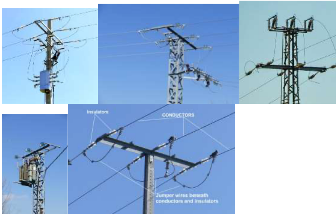
Image 1 : Exemples d'équipement dangereux des lignes (photo J. Martin Martin & A. Camiña)
