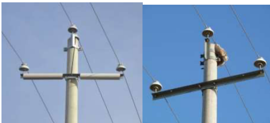
Image 3,4 : Pylône avec goupilles centrales et Sacrer, mort, Mongolie (photo A. Dixon) et modernisé, sans danger pour les oiseaux (photo O. Dorjsuren)
