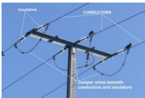
Image 2 : Exemple de conception appropriée des isolants de contrainte (il s'agit de la même configuration que pour les isolants à détente) (photo J. Martin et A. Camiña)
